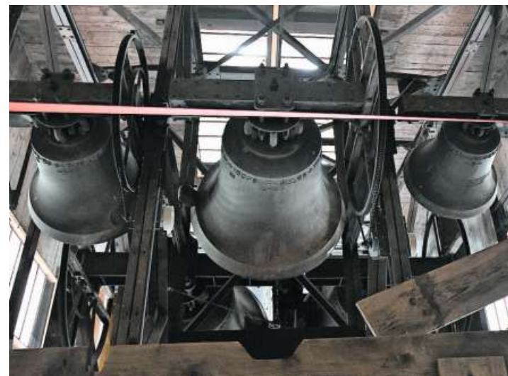
Die fünf Glocken im Turm der evangelischen Kirche Buchs werden seit 1988 elektronisch gesteuert.
