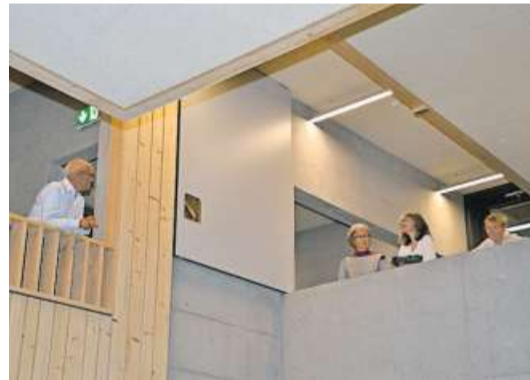
Blick von unten zu den offen gestalteten Durchgängen im Obergeschoss.
